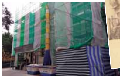
Edificio Azkarate-Enea en obras.
